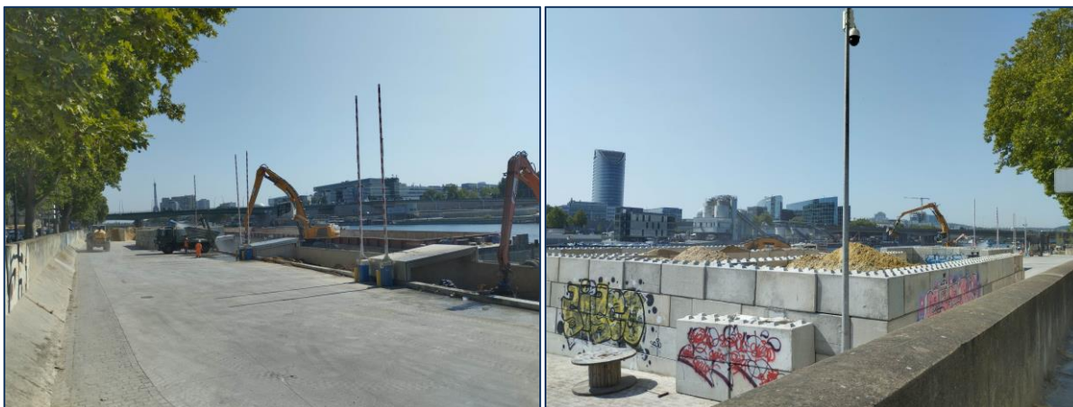
Figure 2 : Illustration des activités présentes au niveau du port du point du jour lors de la campagne de mesures 2023
